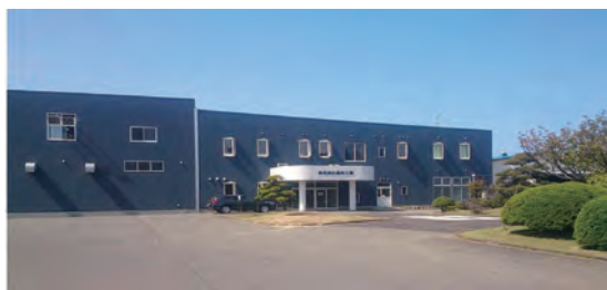
2019年1月完成の新社屋
